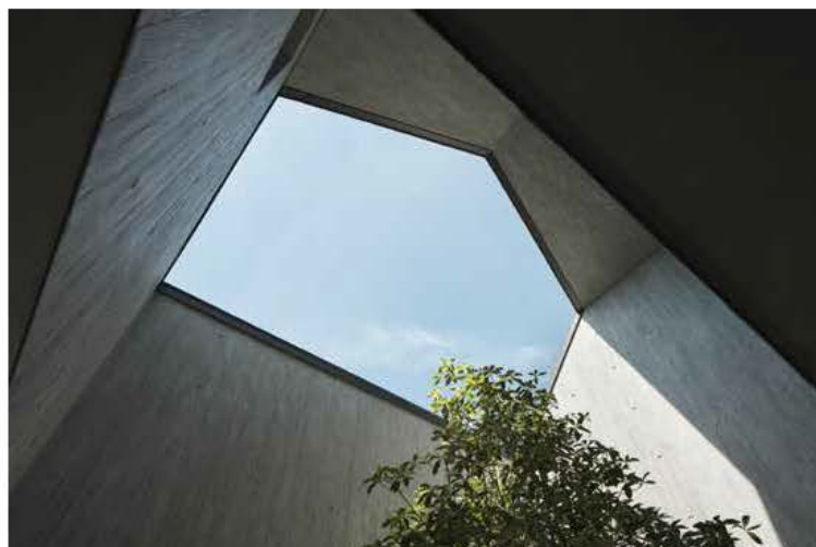
Sopra, il pozzo di luce all’ingresso riprende la forma archetipica degli spioventi, una geometria ricorrente anche in altre parti della casa. Il cemento a vista è testurizzato dalle casseforme. Nella pagina accanto, la piscina arriva a lambire la zona giorno ed è protetta da un muretto di cemento che integra una panchina. • Above, the light well at the entrance echoes the archetypal form of the gables, a geometry that recurs in other parts of the house. The concrete with the patterns of the formwork has been left in view. Opposite page, the swimming pool laps against the living area and is protected by a low concrete wall that incorporates a bench.
